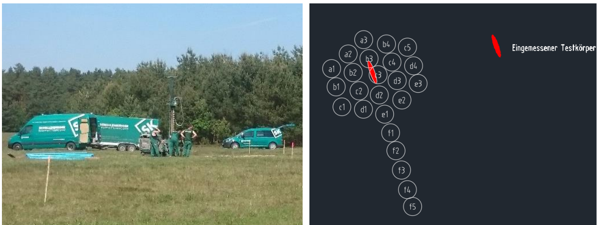
Abb. 3: (a) Durchführung der Bohrarbeiten; (b) Abgeteuftes Bohrraster und Lage des Testobjektes (rote Markierung). Aufmaß mittels RTK-DGPS System.
