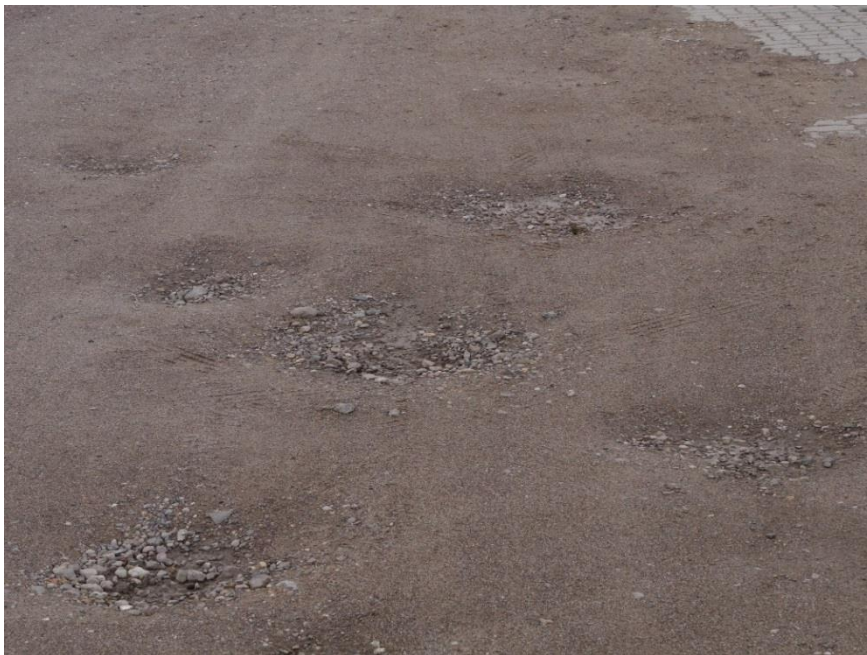
Abbildung 1: Verdichtung und Entmischung von verschiedenen Korngrößen bei einem landwirtschaftlichen Weg. Dabei Hervortreten der groben Bestandteile des Materials an die Oberfläche. Foto: Jens Hagenau.
