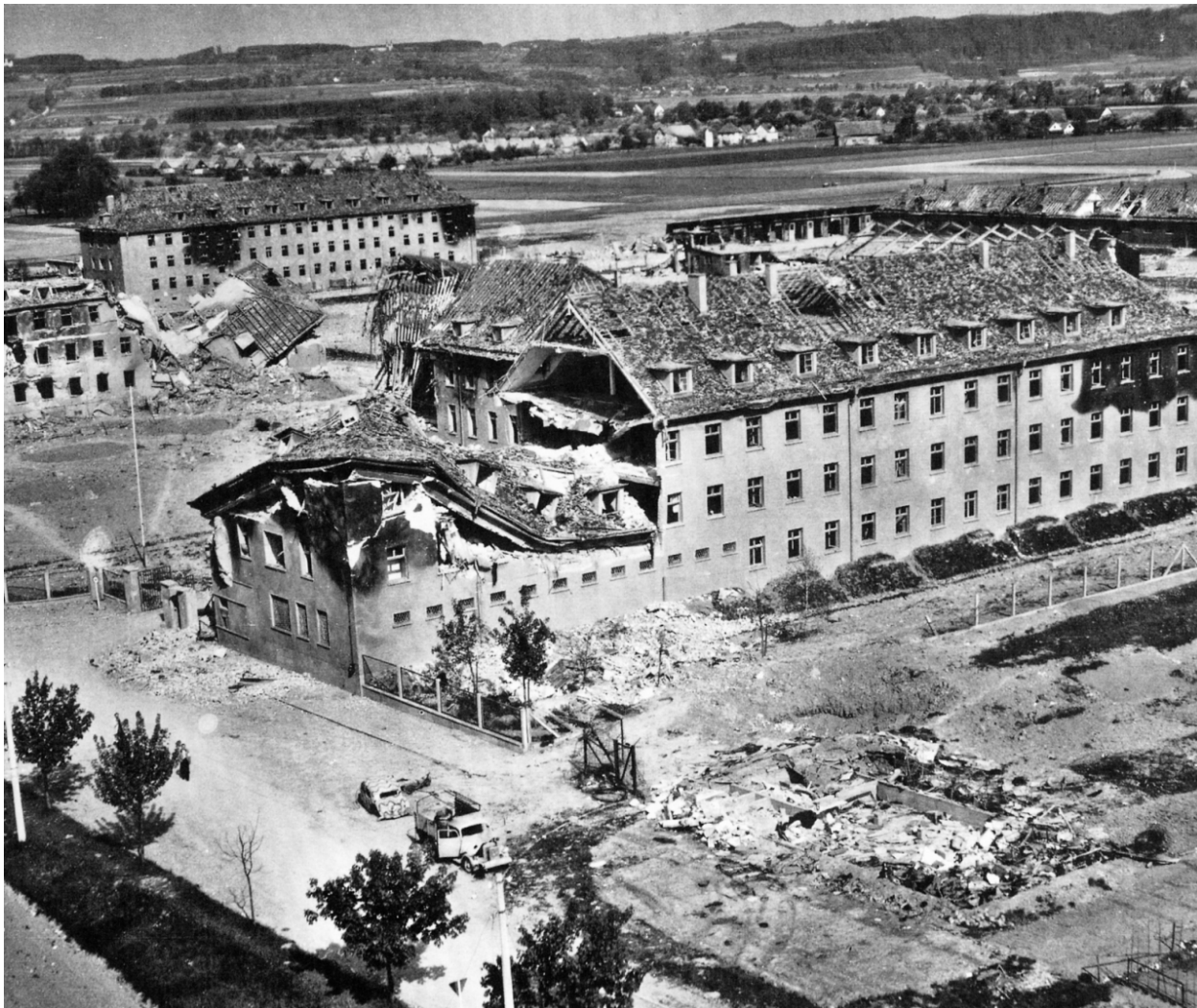
Abb. A-2.1-7 Treffergenauigkeit von Luftangriffen zum Kriegsende, Kaserne bei Weingarten, Schrägluftbild nach dem Angriff aufgenommen zeigt die Zerstörungen (das Gebäude in der Bildmitte entspricht dem ersten Gebäude in der unteren rechten Grundstücksecke im vorangehenden Luftbild (Abb. A-2.1-6))
